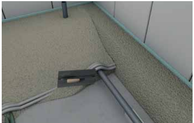
9. Drücken Sie die Fertigmischung an problematischen Stellen in die Ecken und füllen Sie somit die Hohlräume unter den verlegten Rohren etc.
